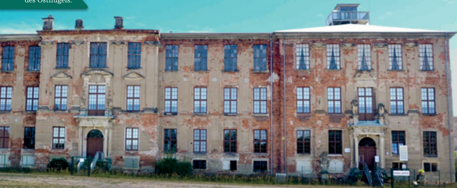
Außenansicht des Ostflügels.
