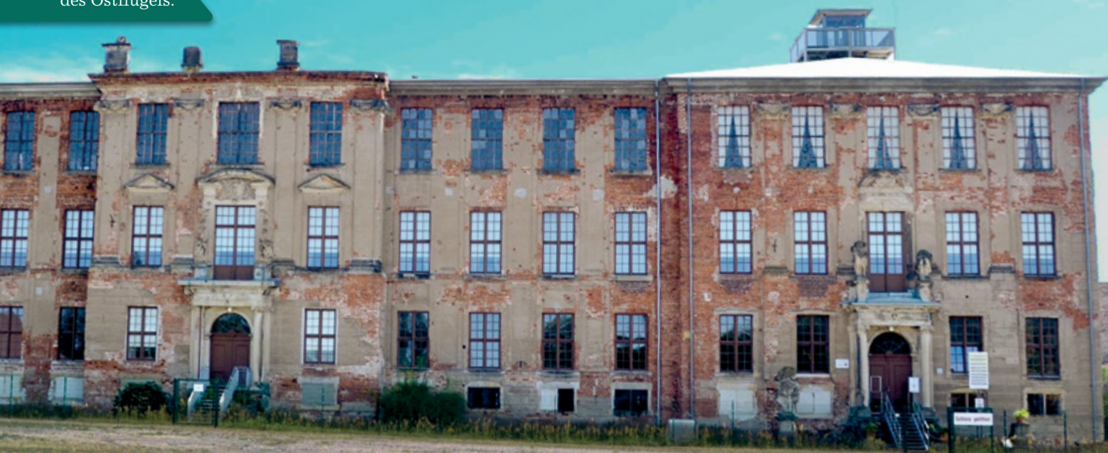
Außenansicht des Ostflügels.
